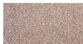
area attrezzata | calcestruzzo architettonico
